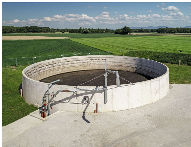
Fig. 5: Rezervor din amestec de beton
